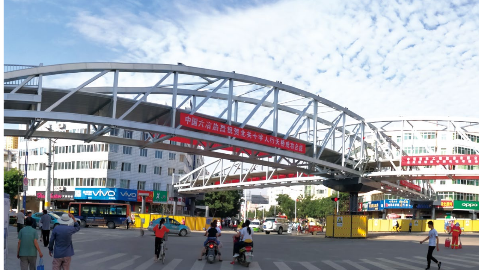
甘肃陇西北关十字人行铝天桥成功合拢，这是六冶重庆分公司与贵阳铝镁设计院合作在甘肃省陇西县修建的西北第一座铝合金天桥，也是中国体量最大的X型天桥
